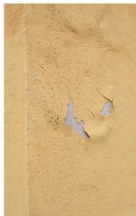
Фасад дома № 6 по улице Приволжской в посёлке Зольное городского округа Жигулёвск после капитального ремонта
